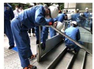
(6) 水防訓練（止水板設置訓練）
